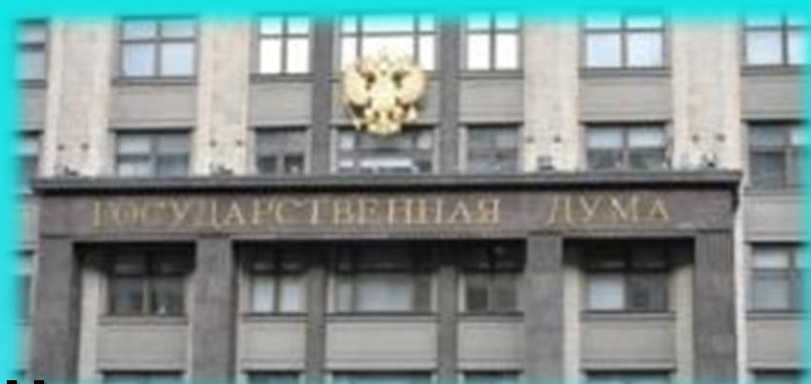
На зданиях госучреждений
